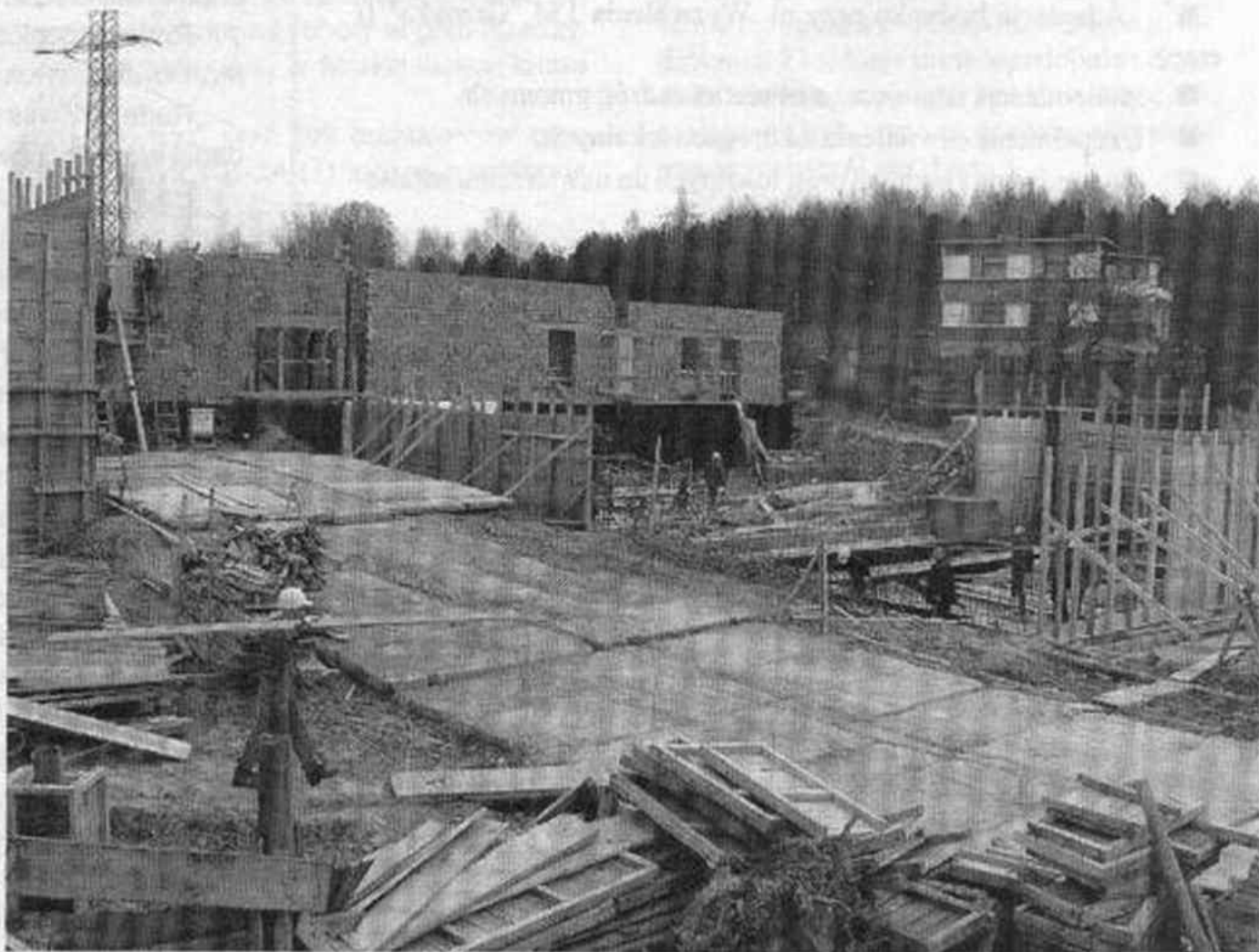
Pod koniec br. planuje się wykonanie stanu surowego zamkniętego budynku gimnazjum
