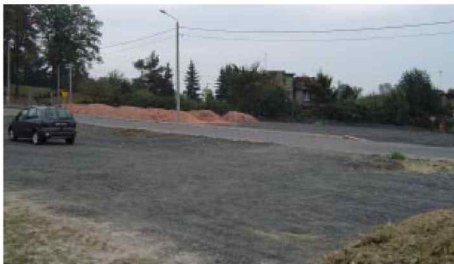
Parking będzie gotowy przed 1 listopada br.
