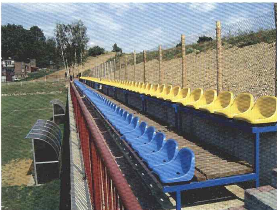
Na nowej trybunie zainstalowano 220 plastikowych krzesel
